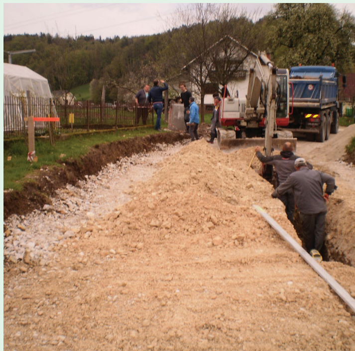
Z deli so začeli na odseku od mostu na Dravinji do Železingerja.
